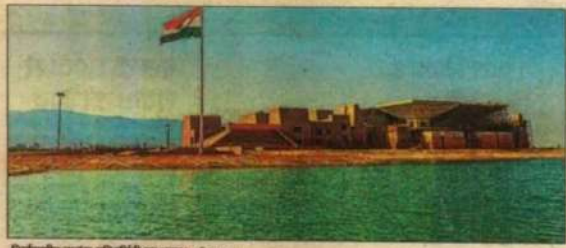
निर्माणाधीन नालंदा यूनिवर्सिटी का भवन। • 8-दृश्य
