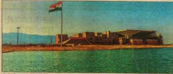
निर्माणधीन नालंदा युनिवर्सिटी का भवन। • हेतुदत्त
