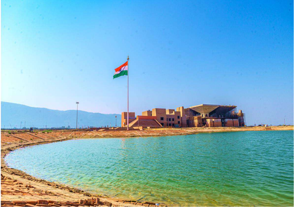
नवीन परिसर, प्रशासनिक भवन
